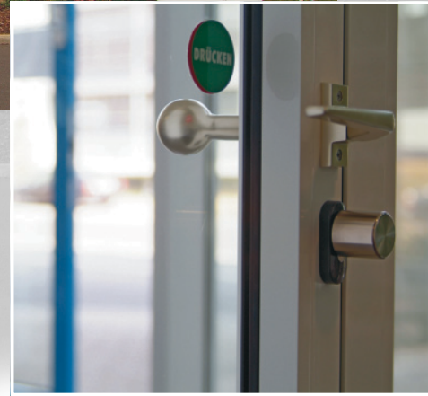
Bild 2: Die Elektronik im Knauf des Zylinders prüft, ob der Schlüssel berechtigt ist.
