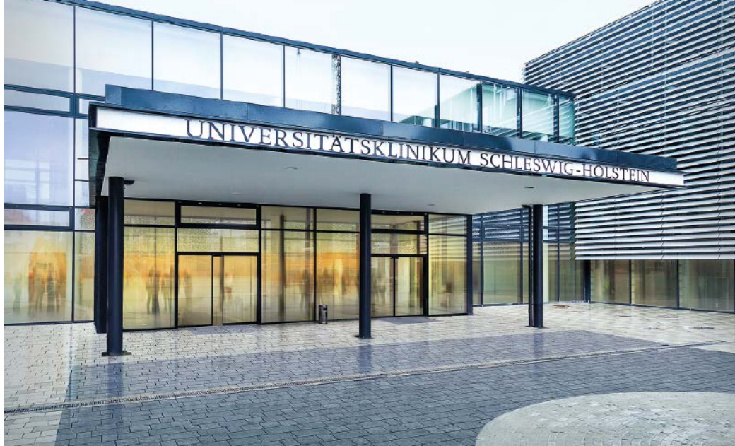
Die elektronische Schließanlage von Uhlmann & Zacher regelt den Zutritt beider Standorte. Im Bild: Eingang zum Campus Lübeck
